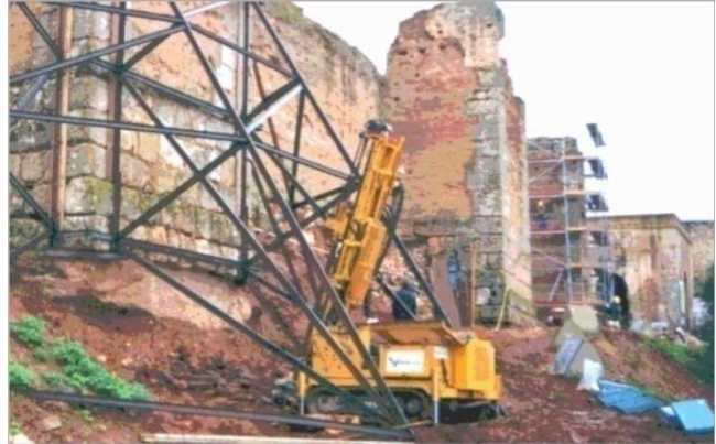
Fig.3.1.1.1 Sonda montada sobre carro de orugas
