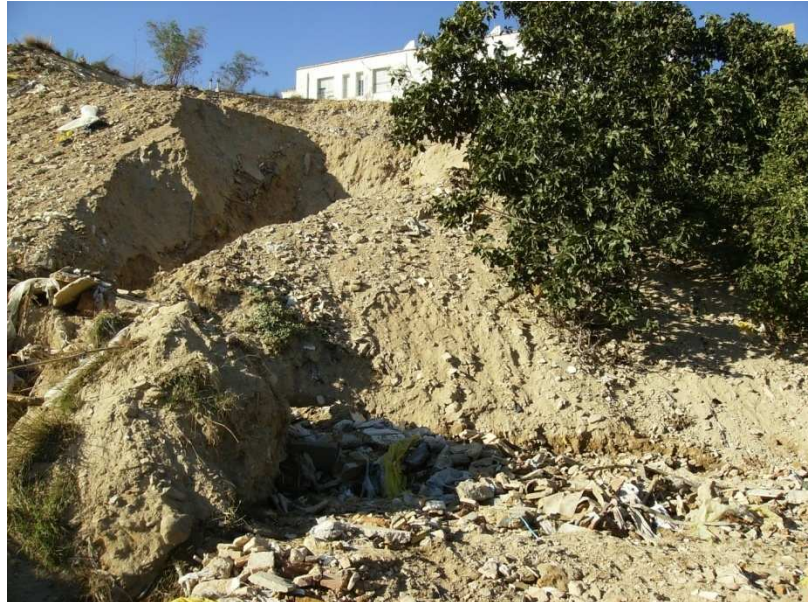
Foto 11.3. Deslizamiento en los rellenos de la zona de la plataforma. (Estos rellenos sueltos pueden dar lugar a avalanchas)
