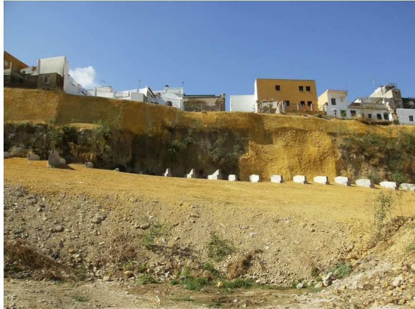
Fig. 6.4. Vista del margen derecho a la altura del pr 0.500 aprox. de la línea de referencia trazada. Donde se puede observar el macizo sobre el que se han llevado a cabo las medidas correctoras y el recubrimiento de rellenos realizado.
