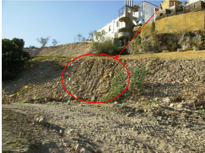
Foto 11.6. Efectos de erosión producidos por escorrentía, en los rellenos.
